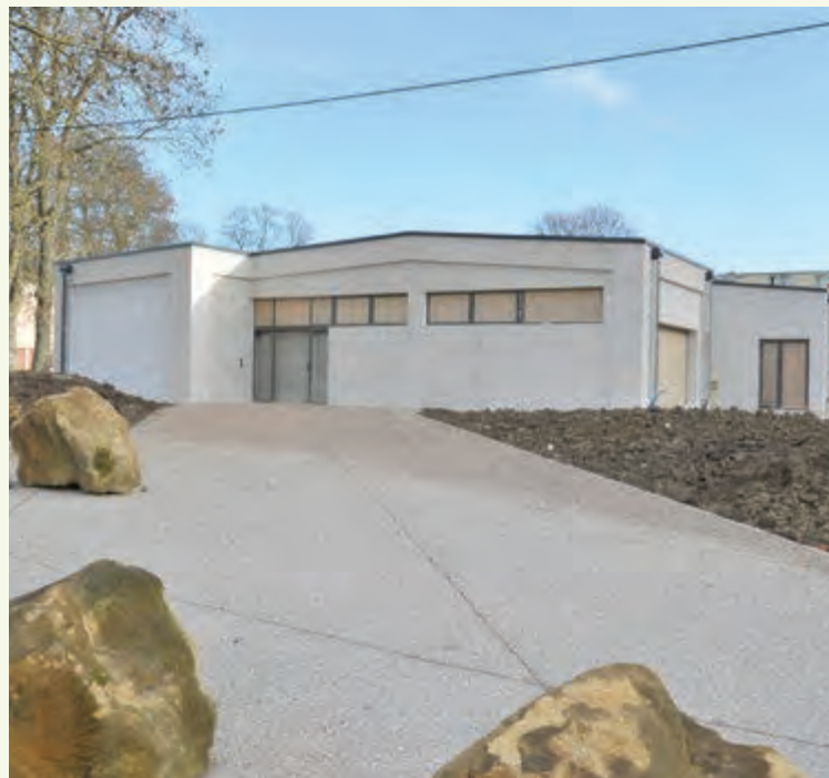
Ci-dessus: la nouvelle Mairie de Quartier de Bellecroix en cours de finition. Située à proximité immédiate du Centre Social et Culturel et de la bibliothèque municipale, son ouverture est prévue le 11 mars 2014.
