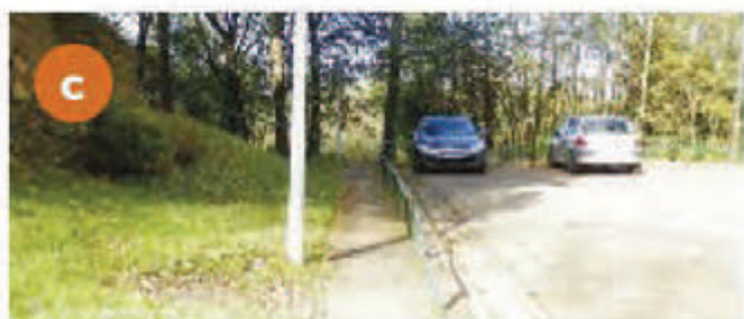
c Garde-corps réduisant le passage et rendant la traversée impossible
