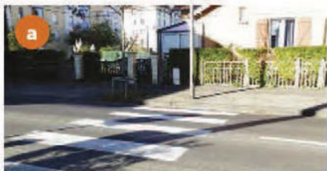
a Passage piéton infranchissable
