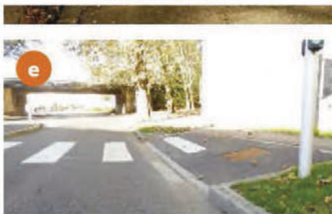
e Pente en travers du trottoir trop marquée
