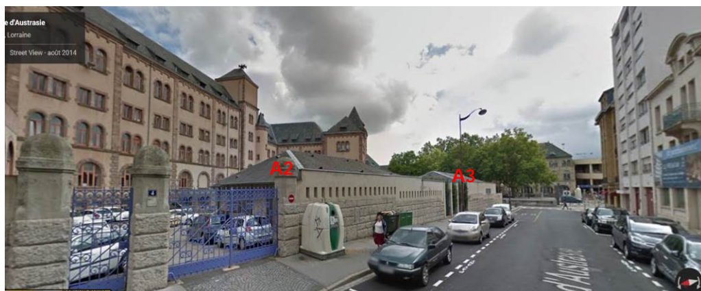
Rue d'Austrasie, vue de la cour C1 et des annexes A2 et A3 adossées à la clôture sur rue
