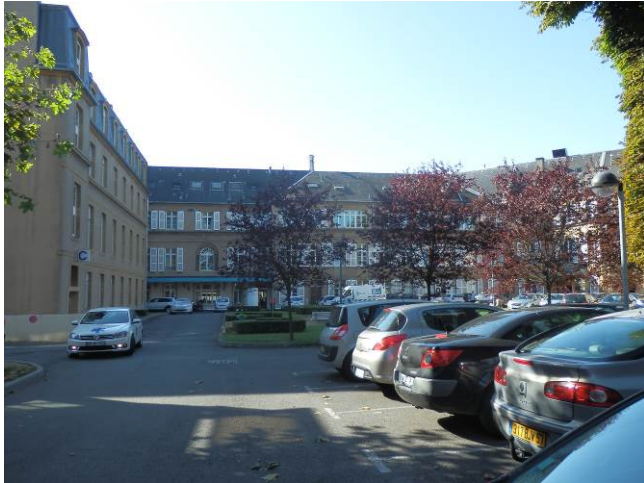
Partie nord de la grande cour (1 et 2)
