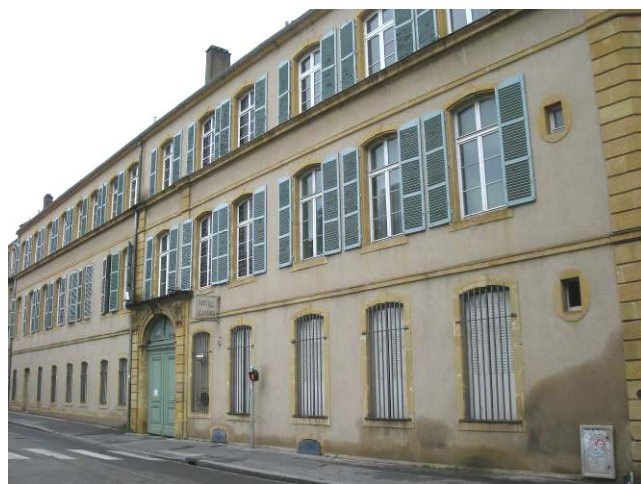
Façade du 4 rue Châtillon (1)
