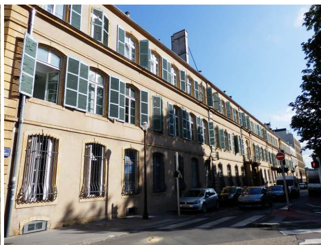
Façade sur le rempart Saint-Thiébault (1, 2 et 3)
